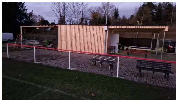
Fundamente und Ständerwände für die Erweiterung der Abstellfläche
